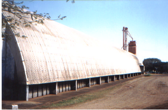
Vista Lateral do Silos
