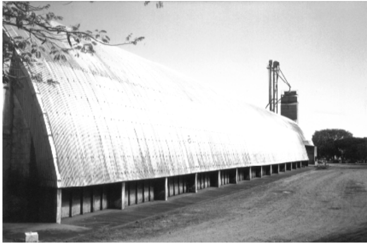
Vista Lateral do Silo
