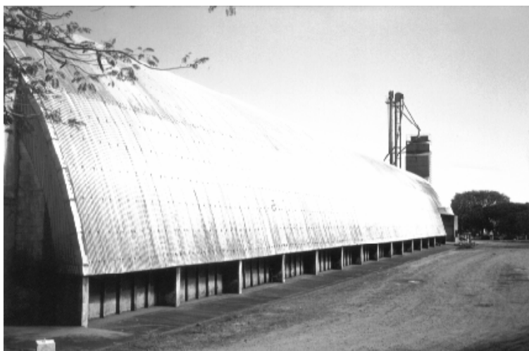
Vista Lateral do Silo
